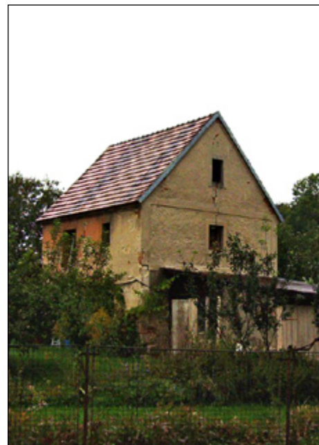
Hospodářská budova u čp. 33
