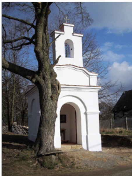
Opravená kaplička na Nedvězí
