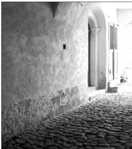
Dlažba v průjezdu památkově chráněného domu čp. 91
