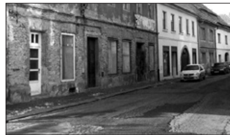
Dlažba v průjezdu památkově chráněného domu čp. 91
