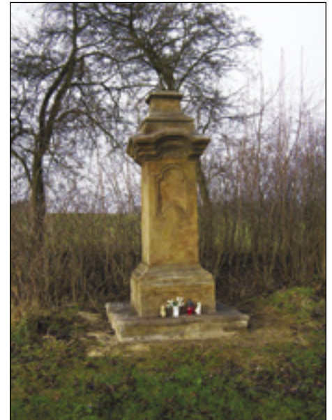
Opravený kamenný sokl
