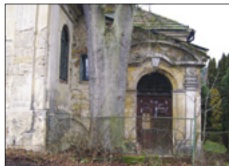
Bývalá kaplička u empirového pavilonu
