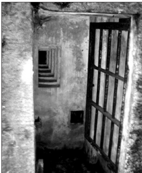
Pohled do bunkru
