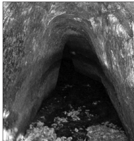
Pohled do štoly u Šibeničního mlýnu
