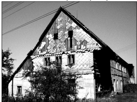
Roubený dům připojený ke zděnému
