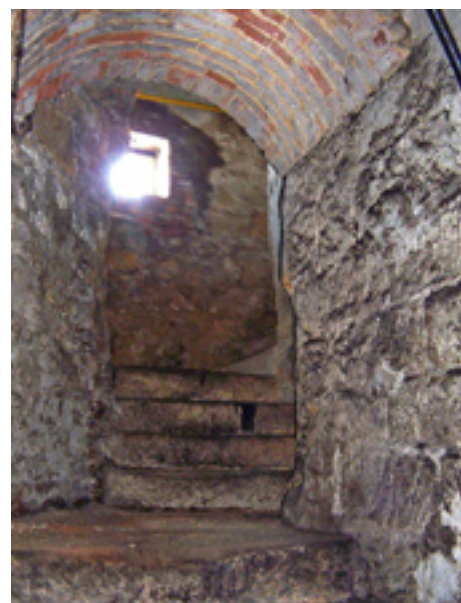
Schodiště do sklepa radnice
