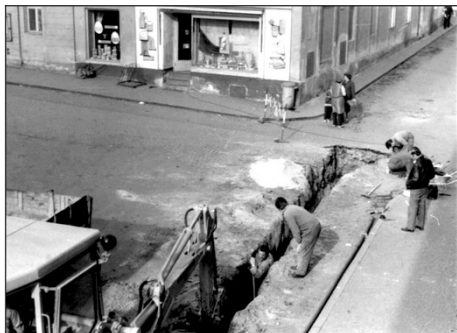
Výstavba centrálního vodovodu v Dubé. Akce TJ Slavoj.
