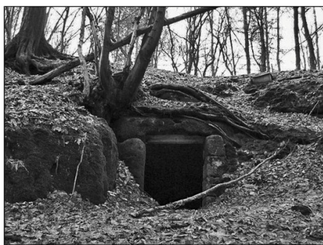
Sklípek domu nad soutěskou
