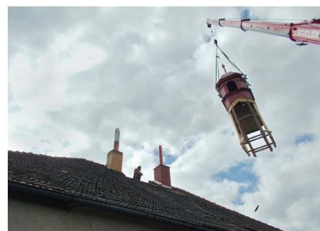
Umísťování hodinové věže zpět na budovu č.p. 42
