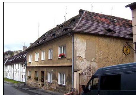
Volská oka na střeše domu čp. 17
