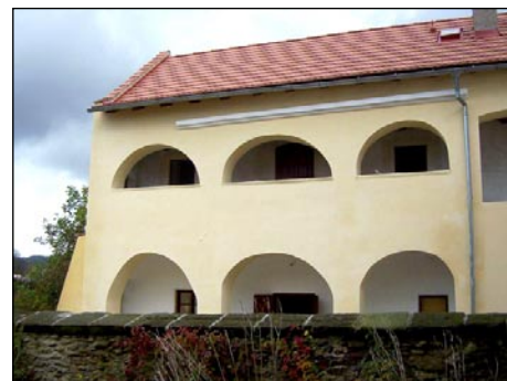
Opravené arkády domu čp. 90
