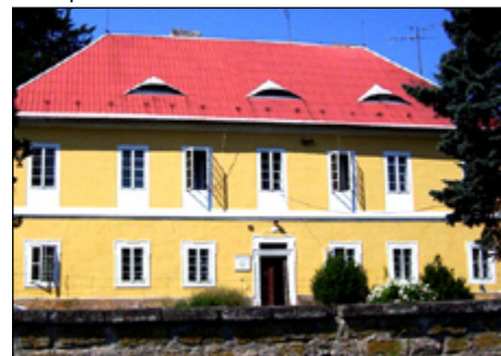
Dvoukřídlová okna osmitabulková – čp. 120
