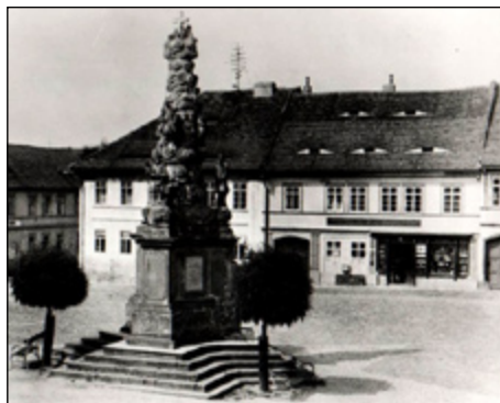
Původní okna čp. 45, 46
