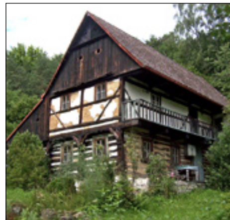
Podstávkový dům s roubeným přízemím a hrázděným patrem v Bukovci
