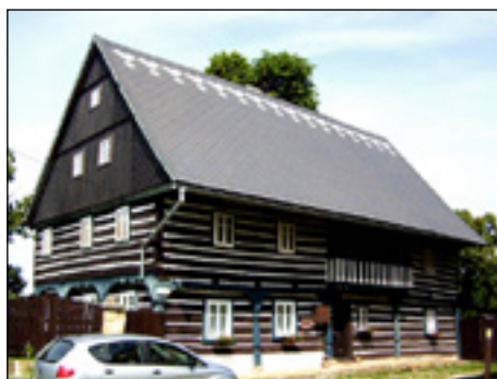
Podstávkový dům s lomenicí a částečně zapuštěnou pavlačí na Dražejově
