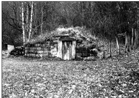
Zbytek domu nad Mlýnkem
