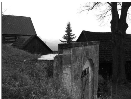
Usedlost s vodárnou
