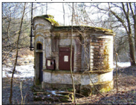
Stavba bývalého dražejovského vodovodu
