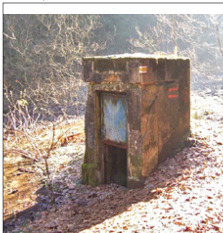
Bývalá vodárna v Pramenném dole
