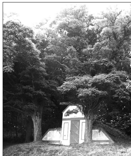
Vodárna nad Křenovem
