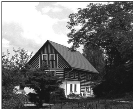
Obnovená roubenka na Křenově
