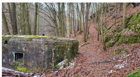
Bunkr, vedle kterého odbočovala pěšina na Křenov
