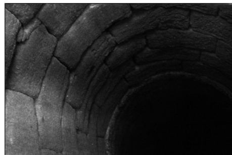
Pohled do staré studny
