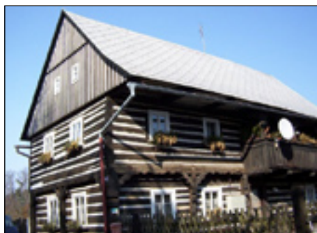
Sedlová střecha z vláknocementových šablon na čp. 94
