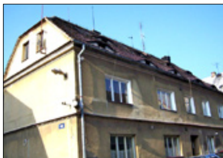
Polovalbová střecha na čp. 17 s unikátními volskými oky, krytá bobrovkami
