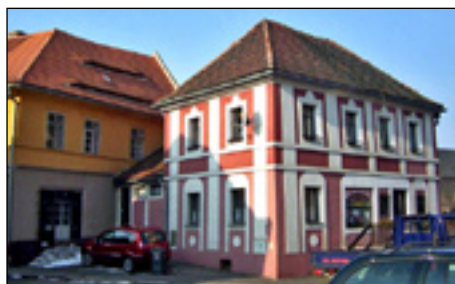
Střecha na čp. 125 a větrací štěrbinu na čp. 126, oboje s korunovou krytinou z bobrovek
