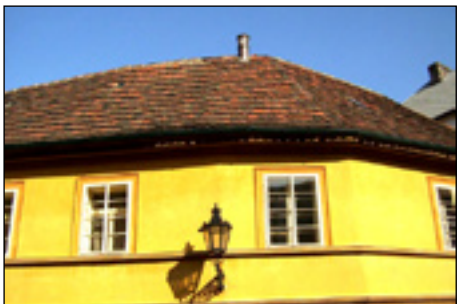
Okrouhlá střecha s korunovou krytinou z bobrovek na čp. 5
