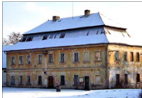
Čp. 12 na Novém Berštejně s mansardovou střechou
