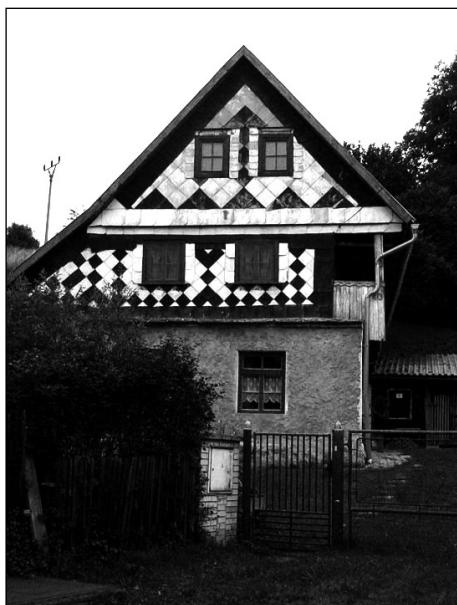
objekt čp. 40 se zděným přízemím a roubeným patrem
