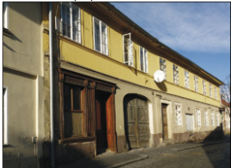
Poštovní ulice čp. 126
