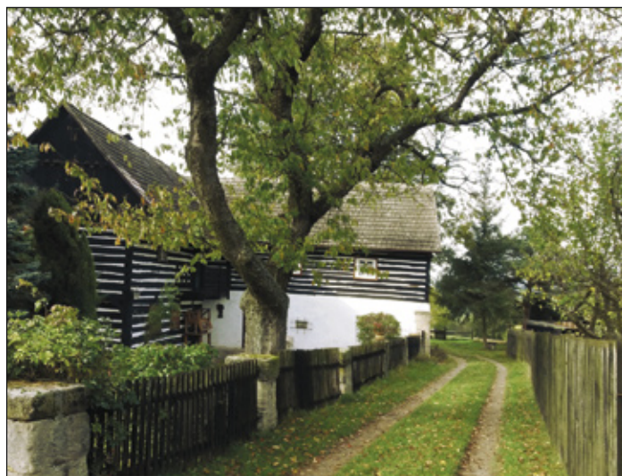
Lidová architektura bývalého Hackelbergu
