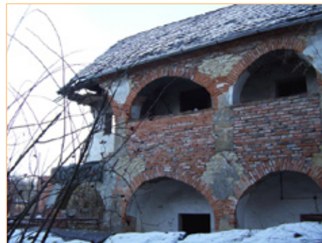
Čp. 90 – nádvořní trakt
