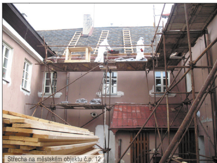
Střecha na městském objektu č.p. 12
