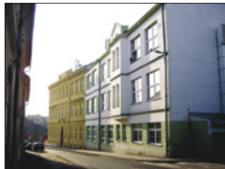
Školní budova z roku 1888 a přístavba z roku 1996
