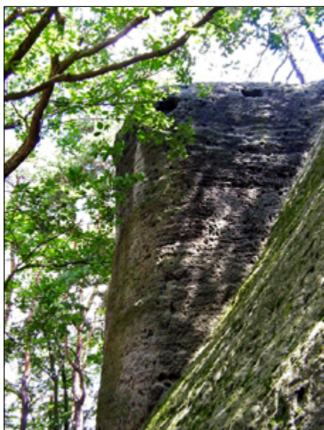
Horní část piliře padacího mostu
