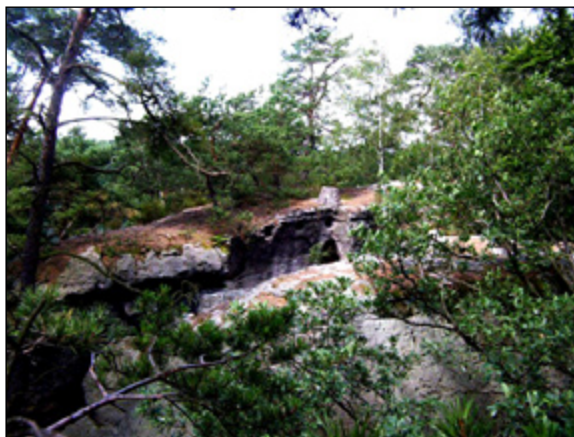
Horní část piliře padacího mostu
