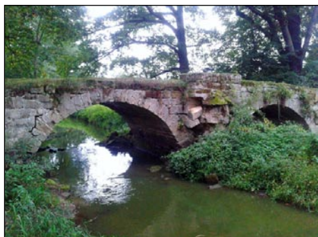
Most přes Bobří potok
