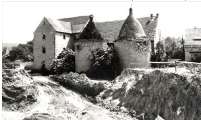
Sušárna v době výstavby odchovny býků
