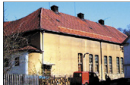
Nástavce staré vzduchotechniky na Slavii
