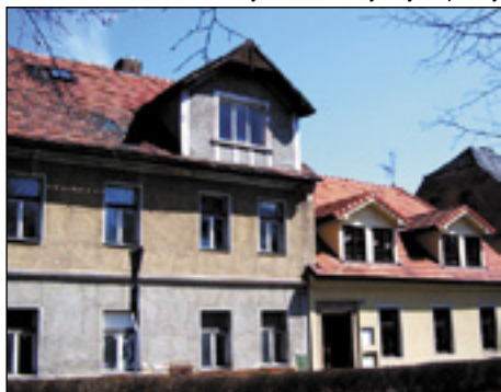
Vikýře v ul. Požárníků
