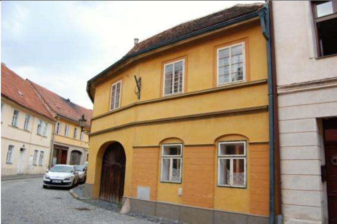
1) Pohled z Poštovní ulice 06/20
