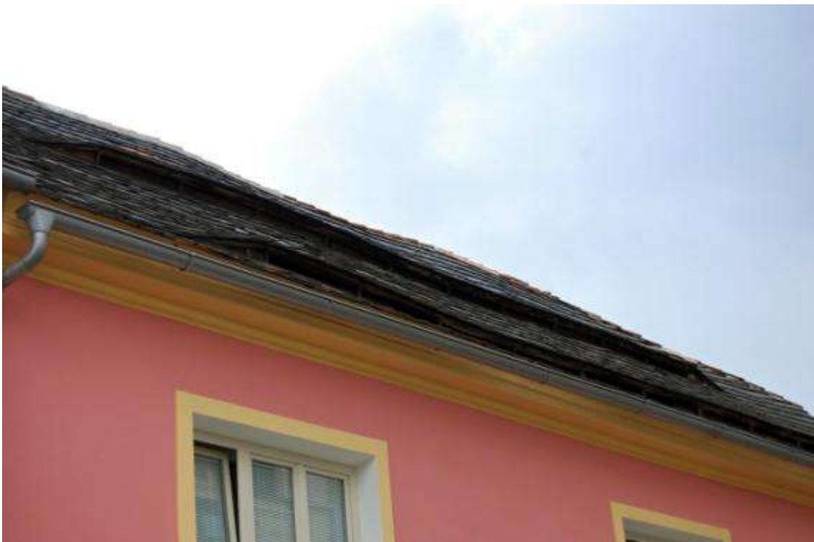
76) Pásové větrací škvíry - pohled z Poštovní ulice 06/20
