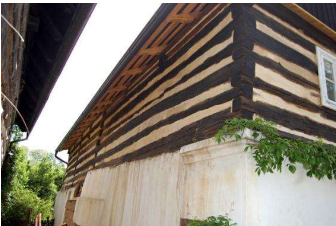
26) Stěna k domu č. p. 97
