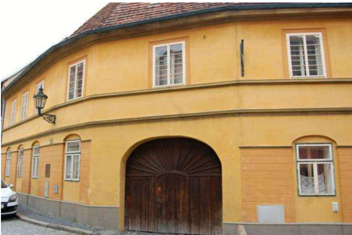
2) Pohled z Poštovní ulice 06/20
