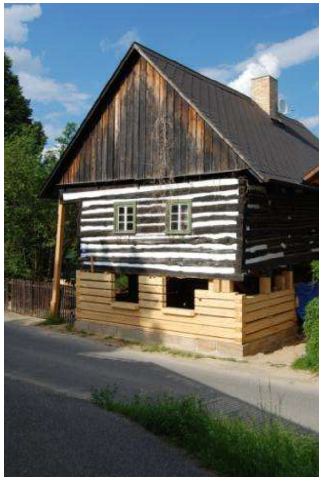
30) Probíhající rekonstrukce - pohled z Dlouhé ulice 07/20
