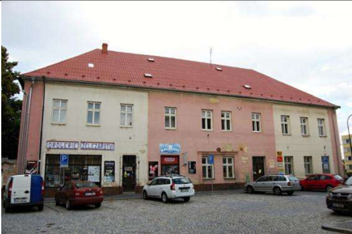
188) Pohled z Poštovní ulice od č. p. 126 06/20
