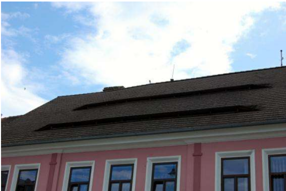
1046) Pásové větrací škvíry 06/20
