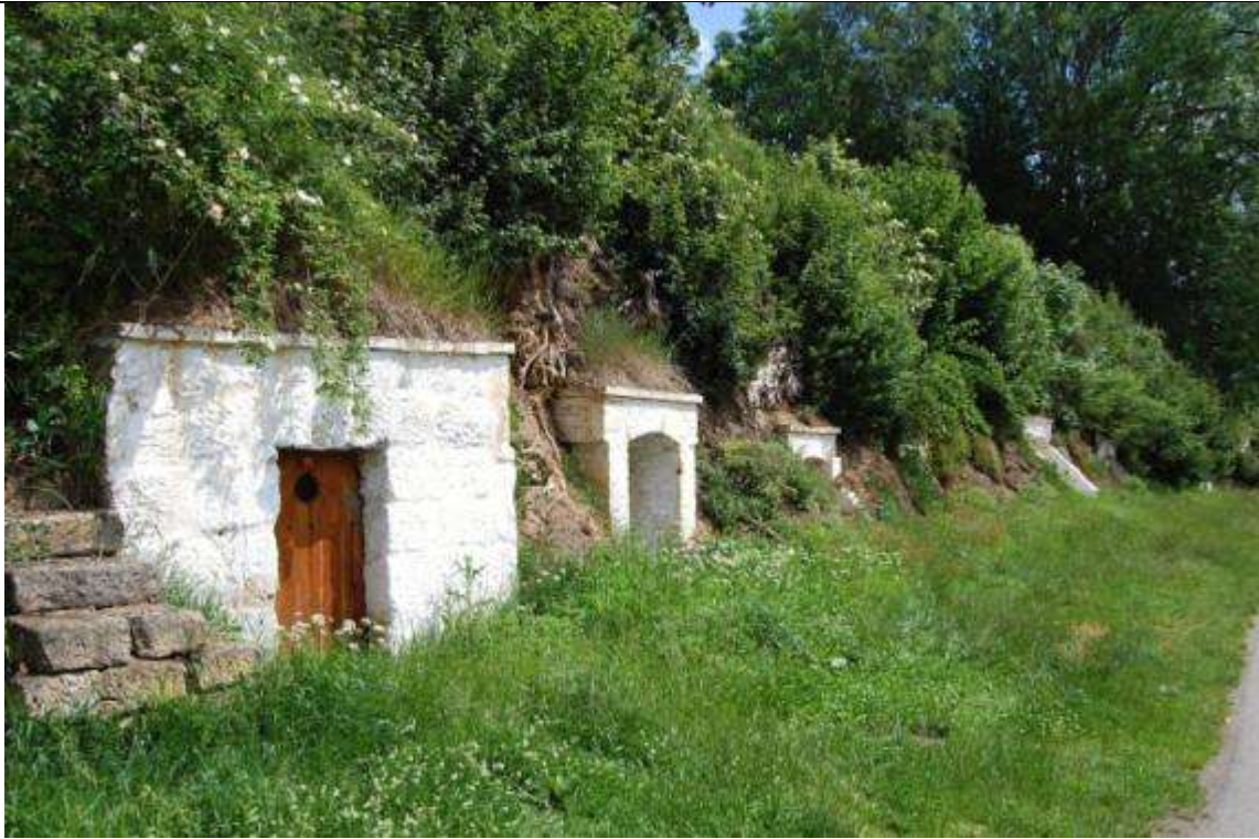
483) Sklípky s opravenými portály v Sadové ulici 06/20
