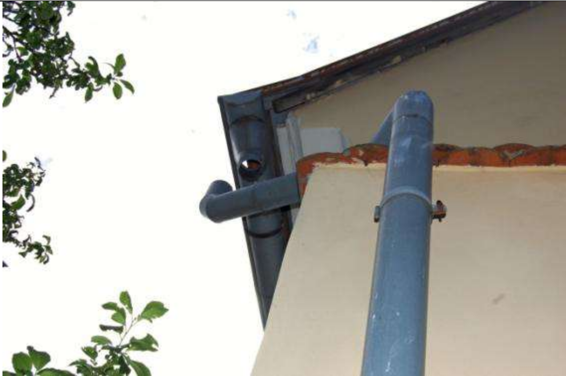
13) Modlitebna - vysazený okapový svod 06/20
