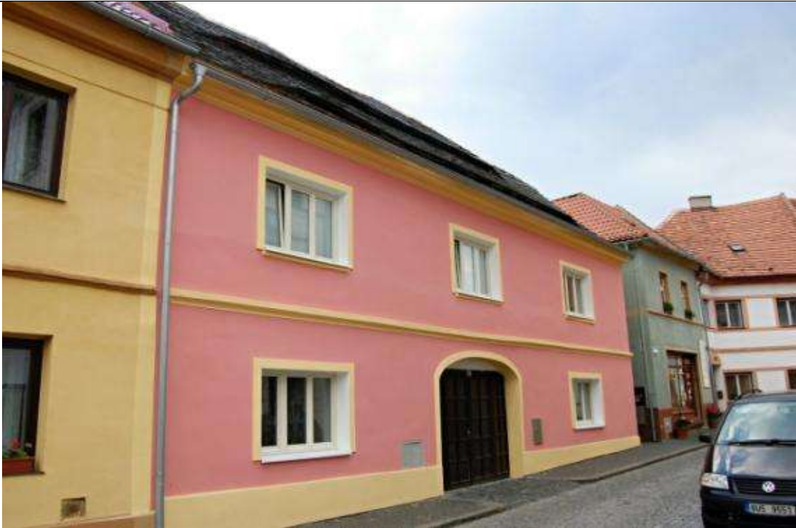
65) Pohled z Poštovní ulice 06/20
