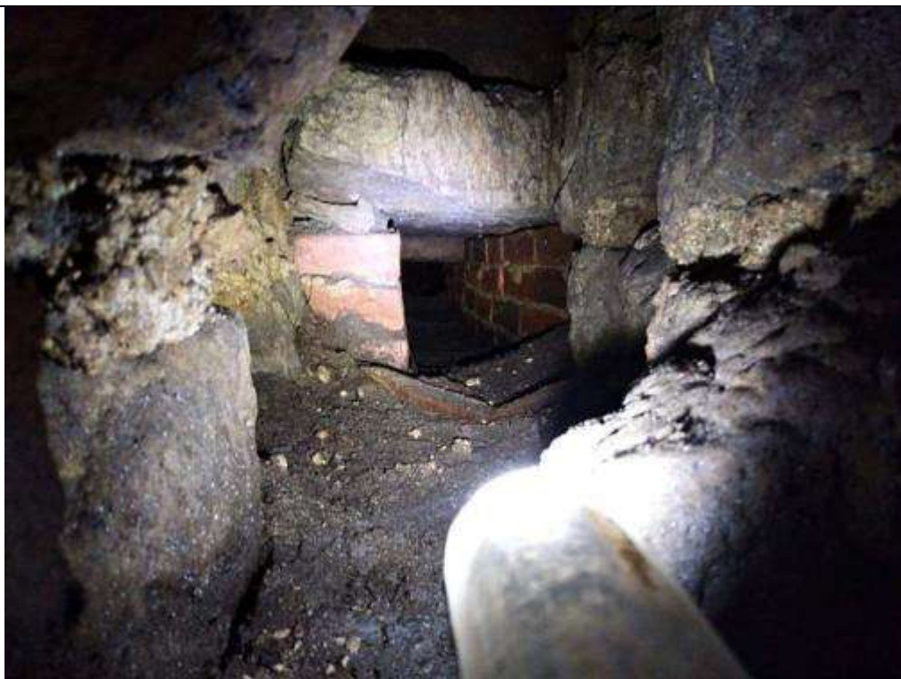
190) Pohled do zazděného odtokového kanálu ze SV sklepa 03/19
