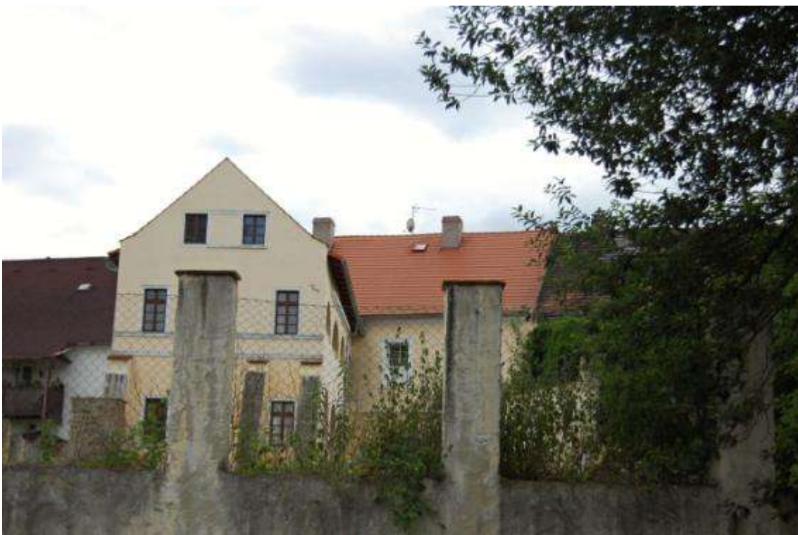
16) Pohled od Malé Strany 07/20
