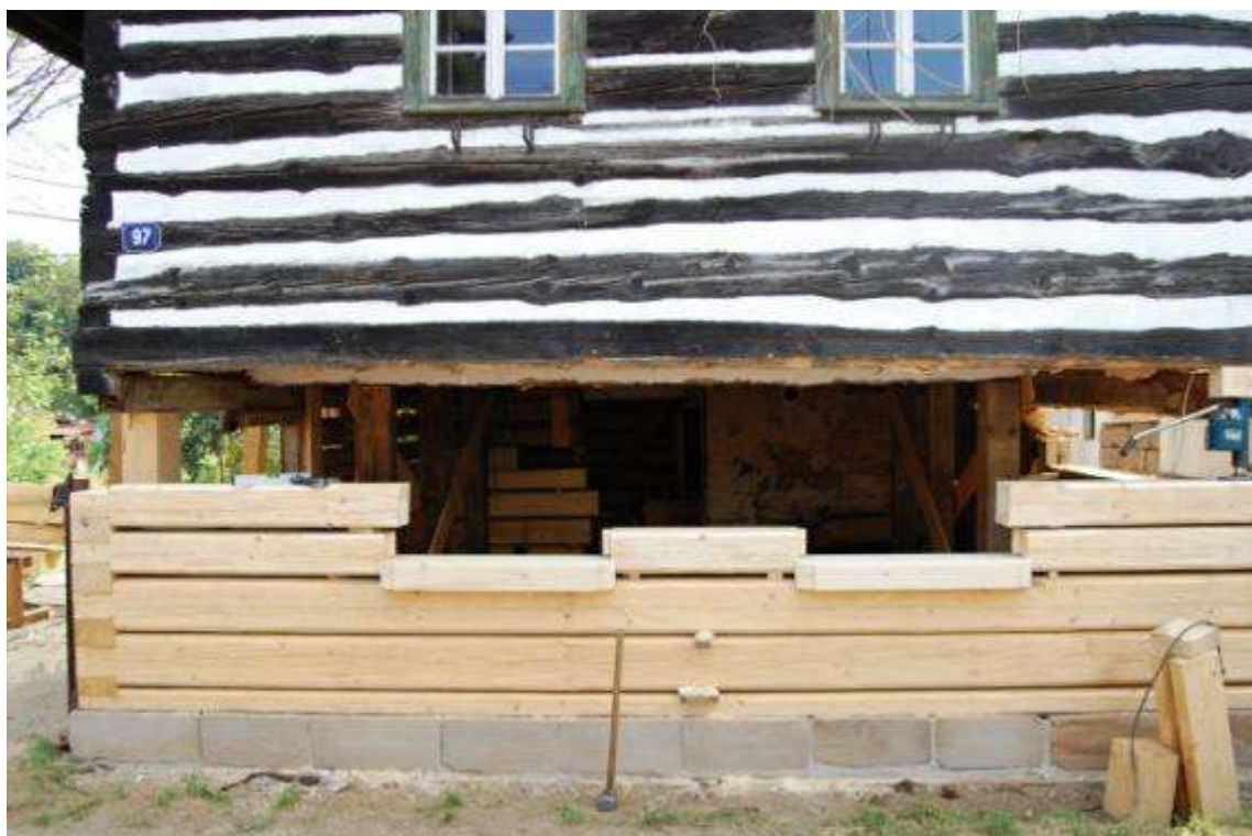
28) Detail probíhající rekonstrukce - pohled z Dlouhé ulice 06/20
