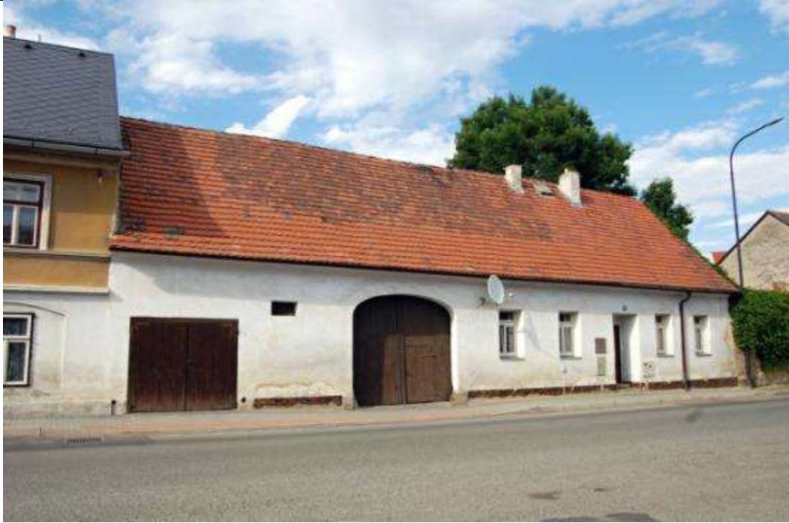
1068) Pohled od hasičské zbrojnice 07/20
