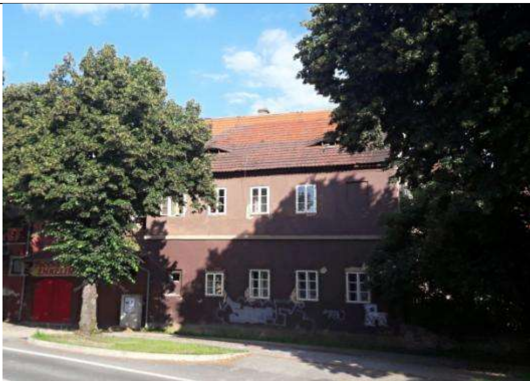
34) Druhá budova - pohled z Českolipské ulice 07/20
