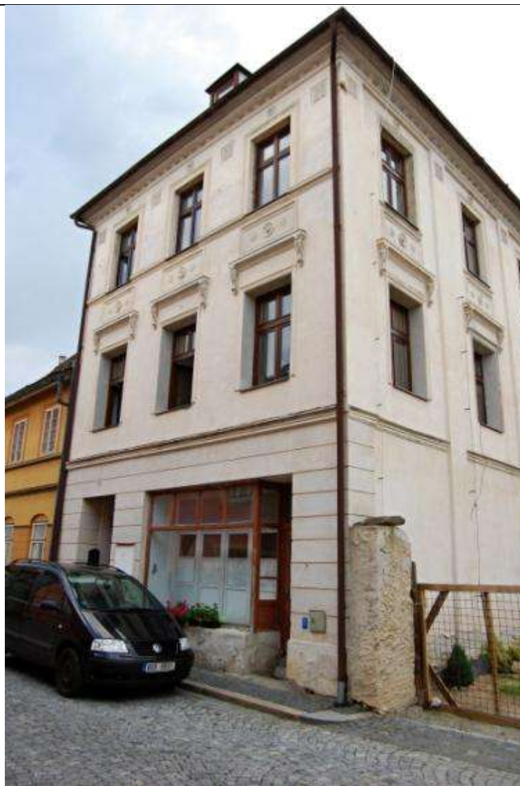
6810) Pohled z Poštovní ulice 06/20
