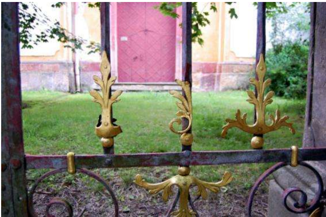
69) Poškození ozdob vandaly 06/20
